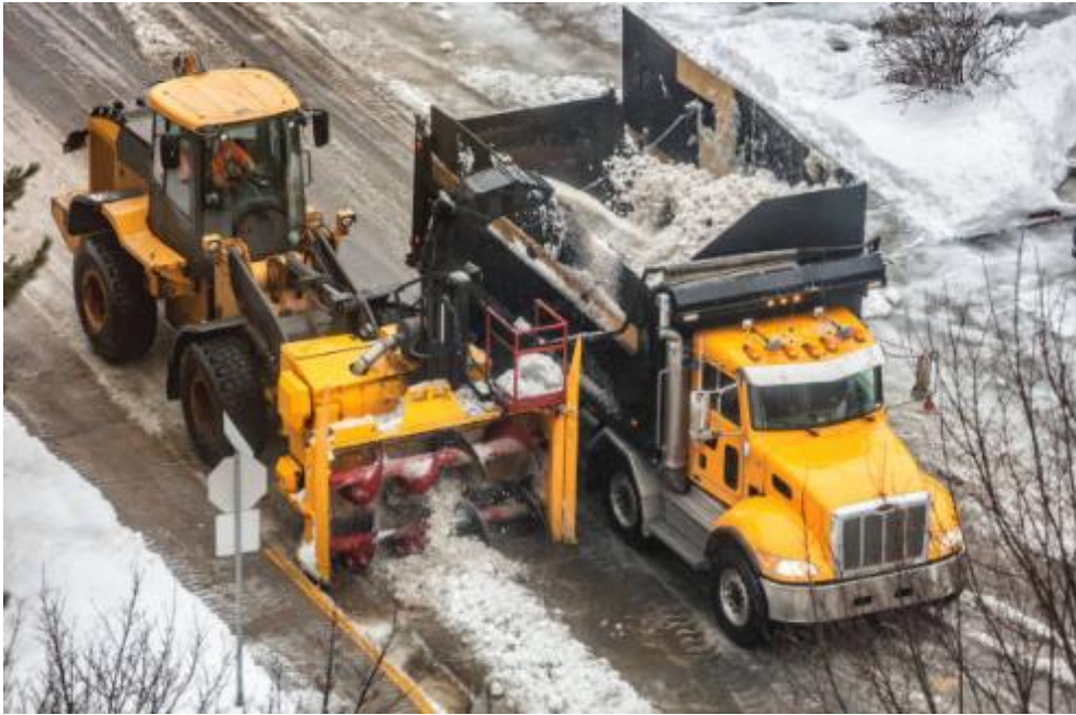
Slika 6b. Bliži opis problema snega i leda na kolovozu.
